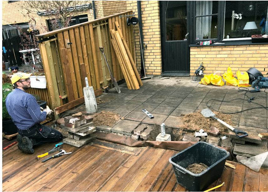
Altanen får inte utökas utan kontakt med styrelsen. Tänk på att vissa tillbyggnader kräver både styrelsebeslut och byggnadstillstånd.
